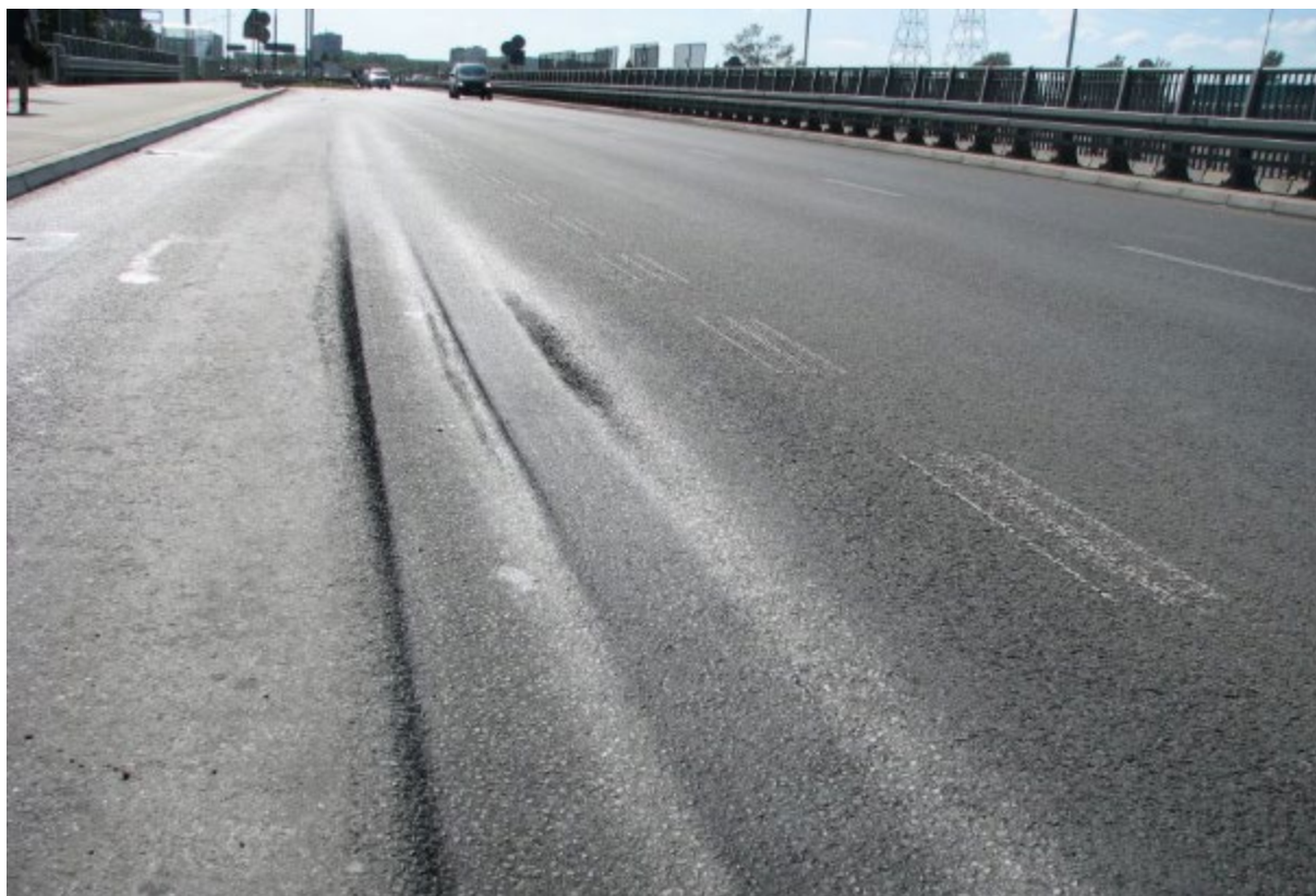
Rys. 5.1.1.1. Nierówności poprzeczne lepkoplastyczne
