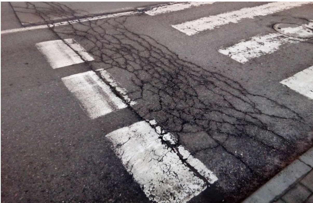
Rys. 5.1.2.5. Przykład spękania zmęczeniowego przy połączeniu technologicznym
