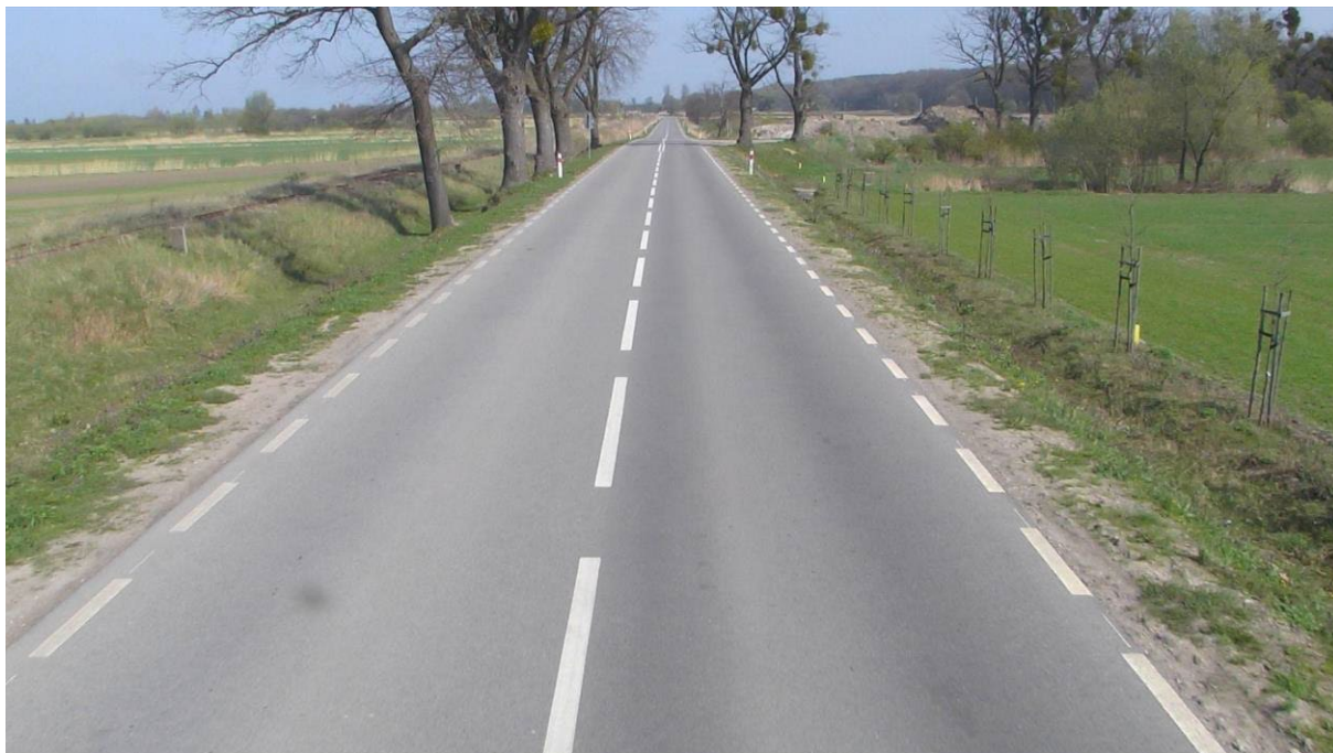
Rys. 4.5.3.2. Przykładowe zdjęcie pasa drogowego wykonane kamerą frontową
