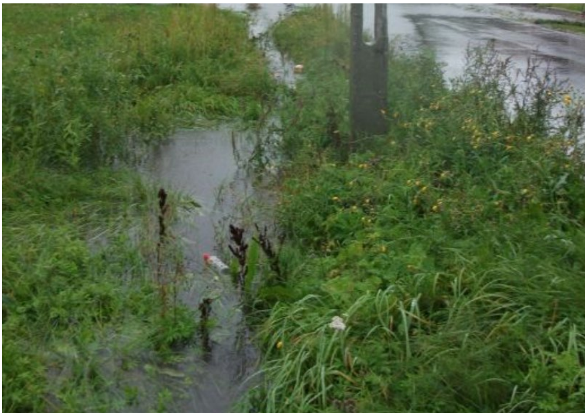
Rys. 7.2.1. Nieregularna linia odwodnienia, rynny zarośnięte chwastami – stan niezadowalający
