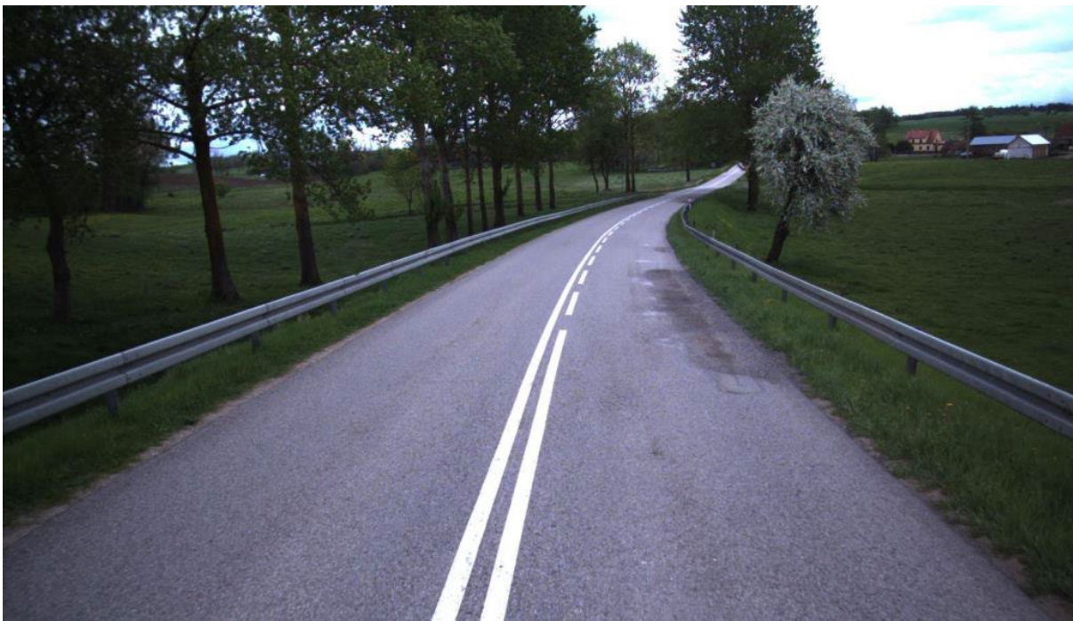
Rys. 5.1.3.5. Stan niezadowalający: łaty zajmujące do 20% powierzchni [6]
