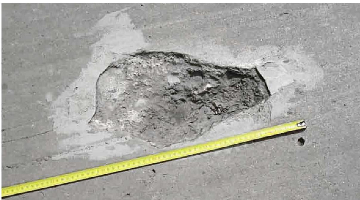
Rys. 5.2.3.8. Widok wyboju
